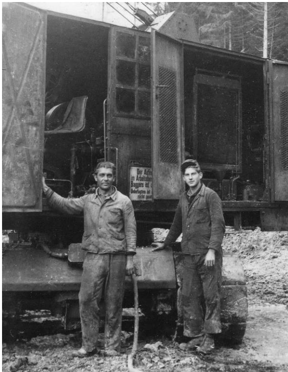
4 Arbeiter am Bagger
