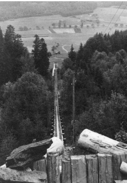
2 Rampe mit Gleis ins Tal, 1947
