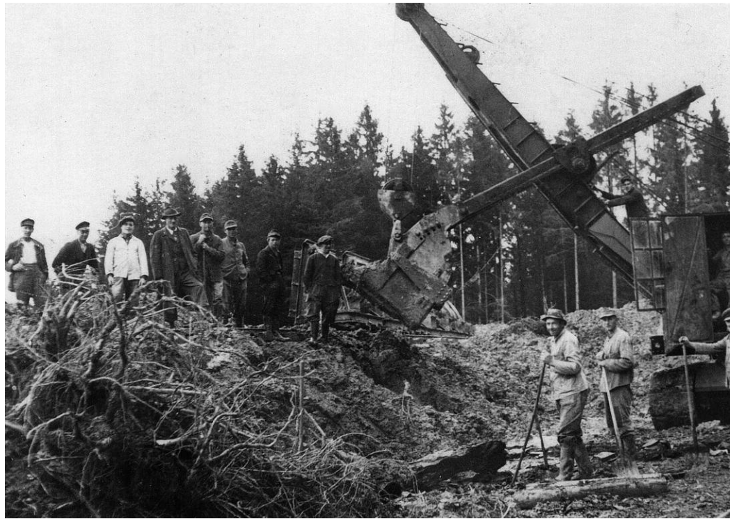
3 Beim Abräumen der Bodenschicht
